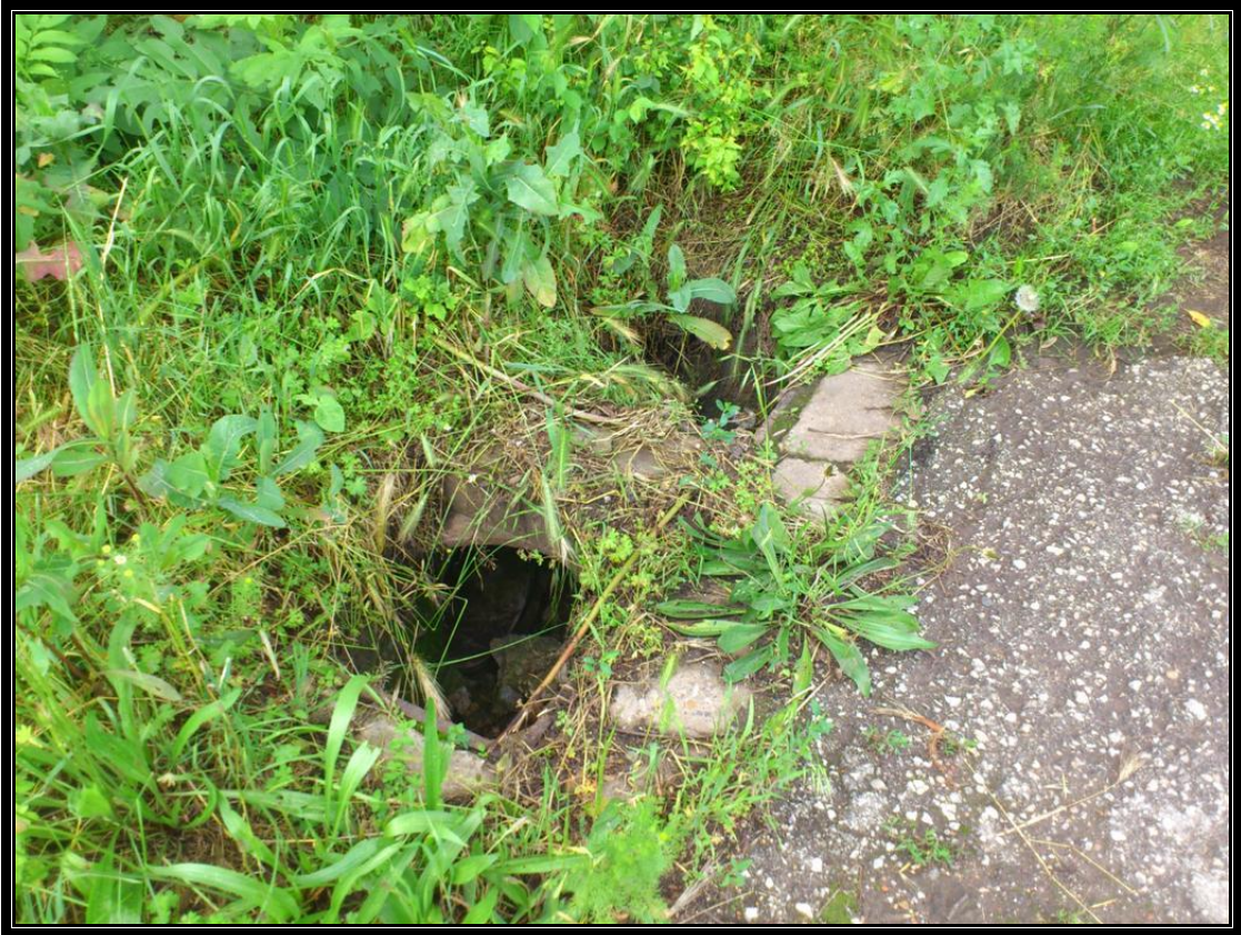
Отводнителни шахти преди моста
